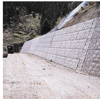
地域連絡林道工石線開設工事 土佐山村高川、高知県林務局、H6/2
