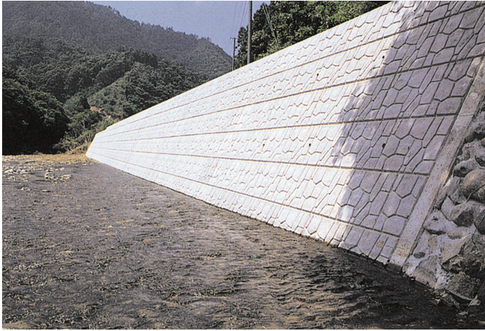
河川災害復旧工事 西土佐村津野川、高知県土木部、H6/6
