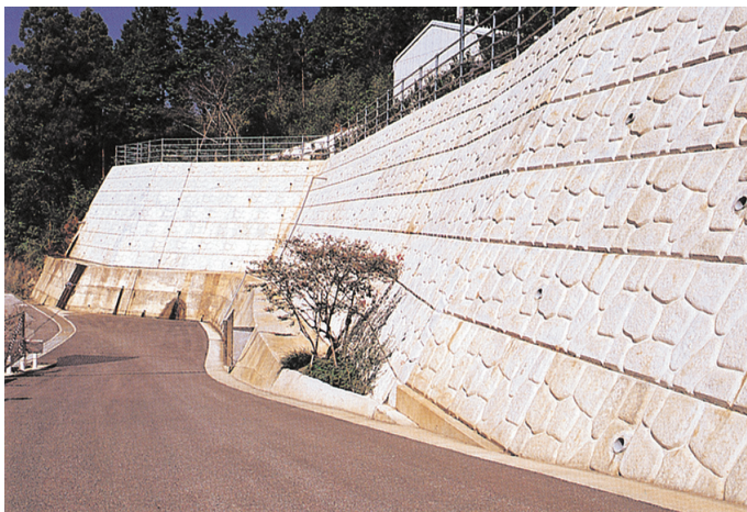
工事用地造成 南国市蒲原、民営、H5/7
