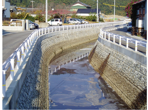
萩谷川広域河川改修工事 土佐市宇佐、高知県土木部、H22/6
