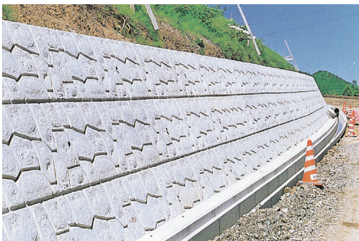
県道カルスト公園線改良工事 東津野村郷、高知県土木部、H6/1
