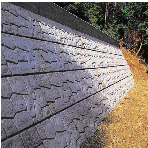
林道松原線道路災害復旧工事 吾川村田村、吾川村、H6/9
