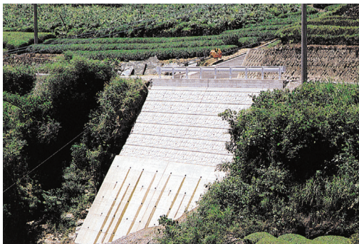
町道小郷線道路災害復旧工事 池川町坂本、池川町、H6/5
