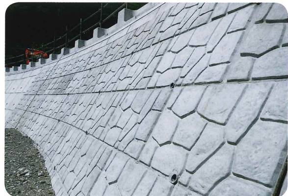
<施工実績> 国道494号防災・安全交付金工事 (高知県越知事務所発注)
